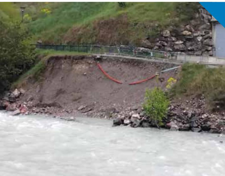
entraînant un glissement du talus. Les équipements « voie verte » et « voirie d'accès aux silos à sel » ayant été directement impactés, il a été décidé de reconstituer un enrochement permettant de sécuriser la berge.
