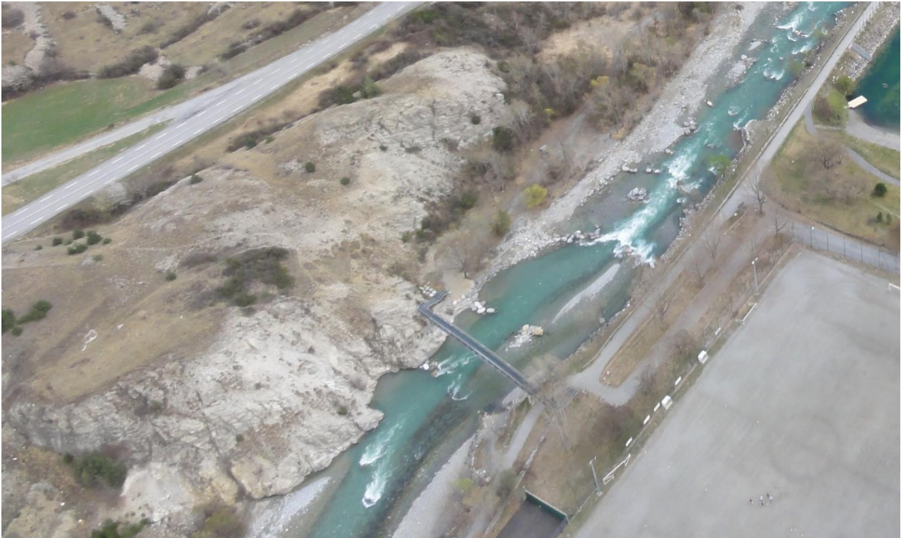
Figure 11 : Photographie du secteur du stade d'eau vive en 2012 (ARTELIA)
