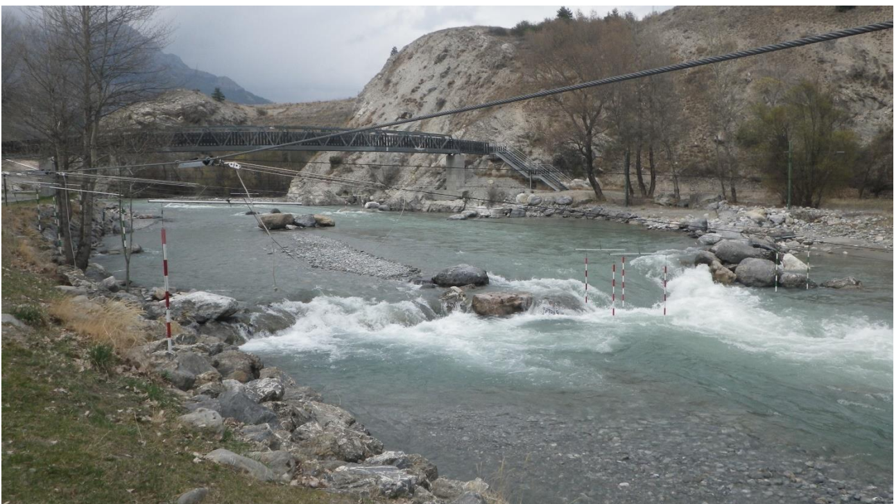
Figure 12 : Photographie du seuil en aval de la passerelle en 2012 (ARTELIA)
