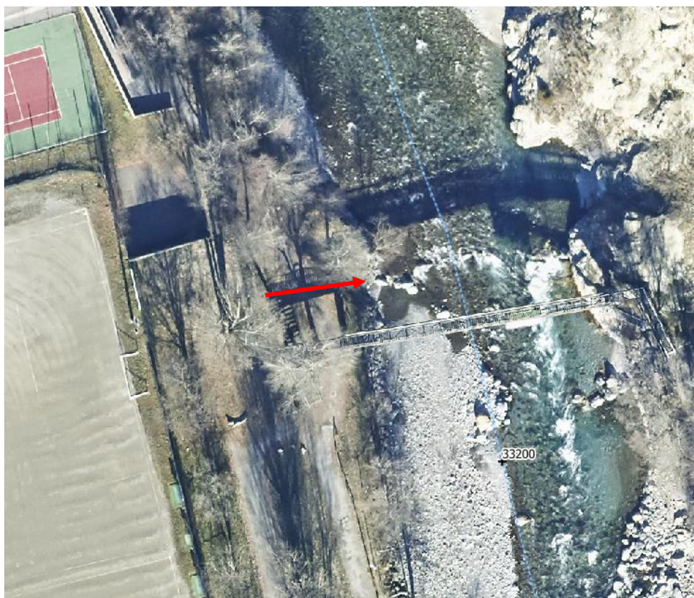
Figure 9 : Seuil visible sur la photographie aérienne de décembre 2024
