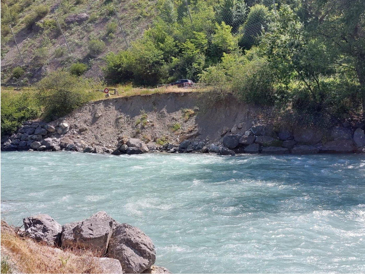
Figure 14 : Photographie de l'anse d'érosion rive gauche en limite aval du stade d'eau vive, en juin 2025 (ARTELIA)
